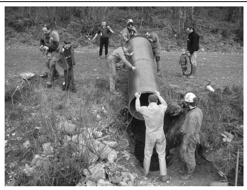
Mise en place de la buse dans l'entrée de l'Alliance 1
